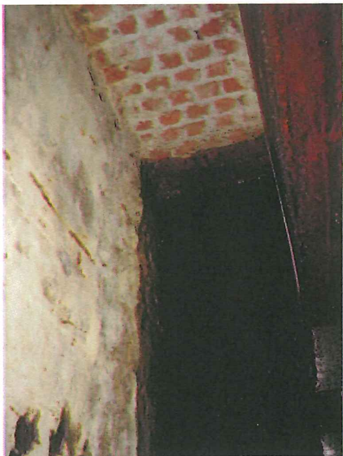
Photo 7 : murs du local des citernes imbibés de mazout
