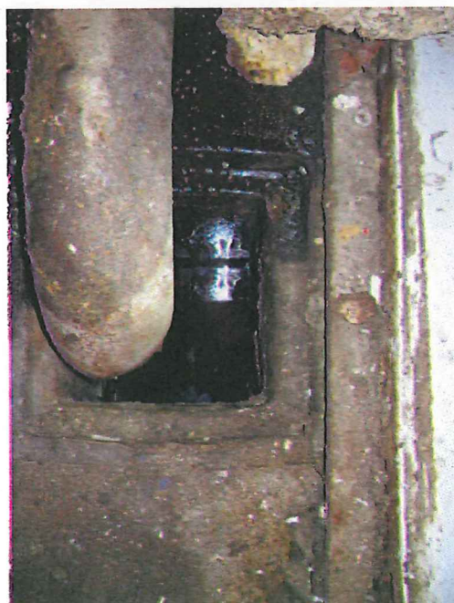
Photo 3 : mazout dans le sterfput
