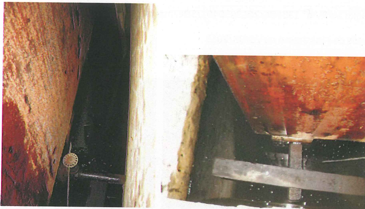
Photo 4& 5 : couche de mazout autour des citernes dans le local des citernes
