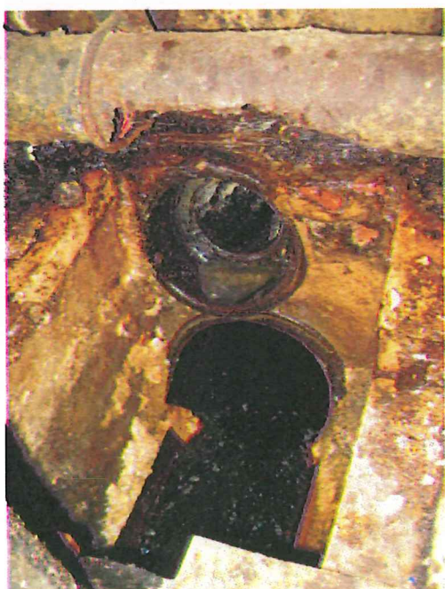
Photo 2 : écoulement du mazout dans les égouts
