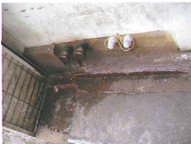
Photo 8 : traces de mazout autour du point de remplissage
