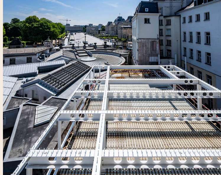
Gelijkvloers van het museum in aanbouw ▲
